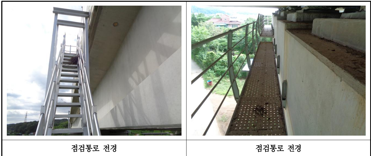
【사진 28.3.25】 교량 점검시설 전경
