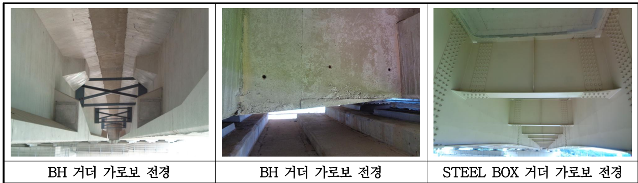
【사진 28.3.6】 가로보 전경
