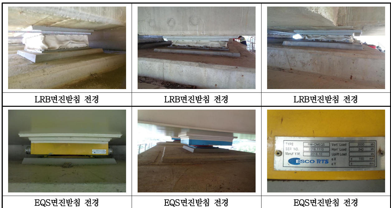
【사진 28.3.12】 교량받침 전경
