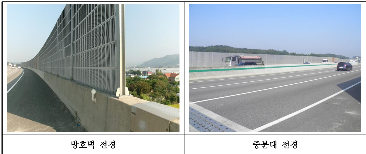
【사진 28.3.23】 방호벽 및 중앙분리대 전경
