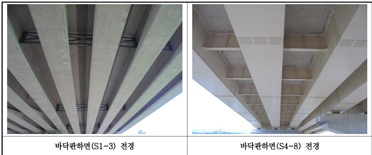
【사진 28.3.2】 바닥판하면 전경
