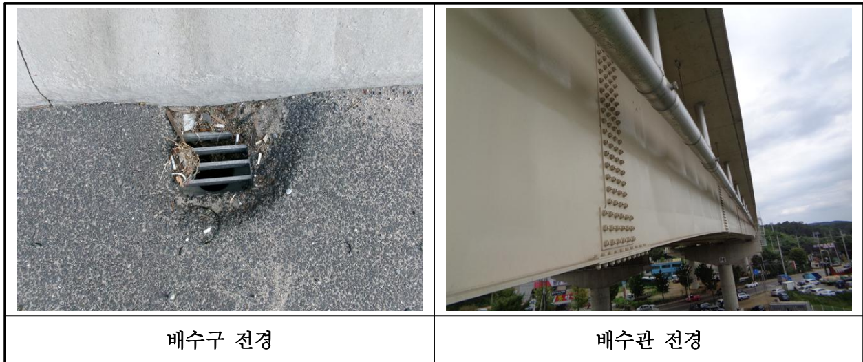
【사진 28.3.21】 배수시설 전경
