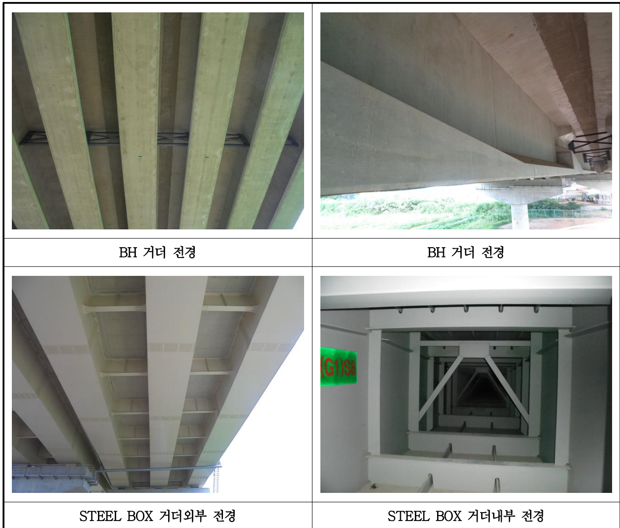
【사진 28.3.4】 거더 전경
