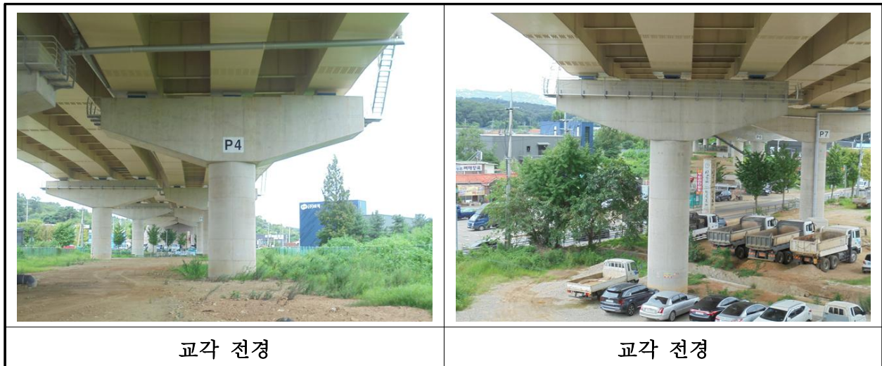
【사진 28.3.10】 교각 전경
