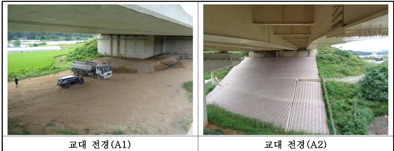
【사진 28.3.8】 교대 전경
