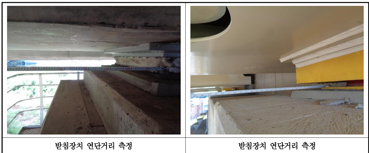
【사진 28.3.14】 교량받침장치 연단거리측정
