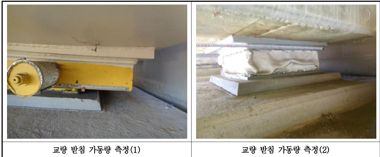
【사진 28.3.15】 교량받침 이동량 측정
