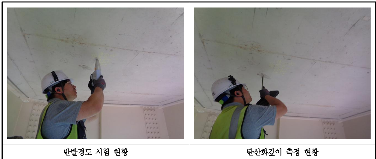
【사진 28.4.1】 콘크리트 내구성조사 현황
